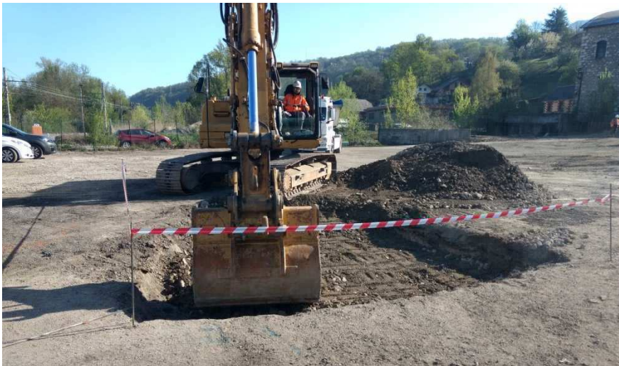
Remblaiement par couches successives avec des matériaux sains
