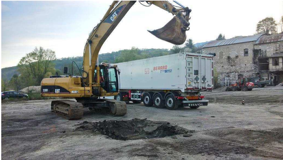
Chargement des terres dans la benne
