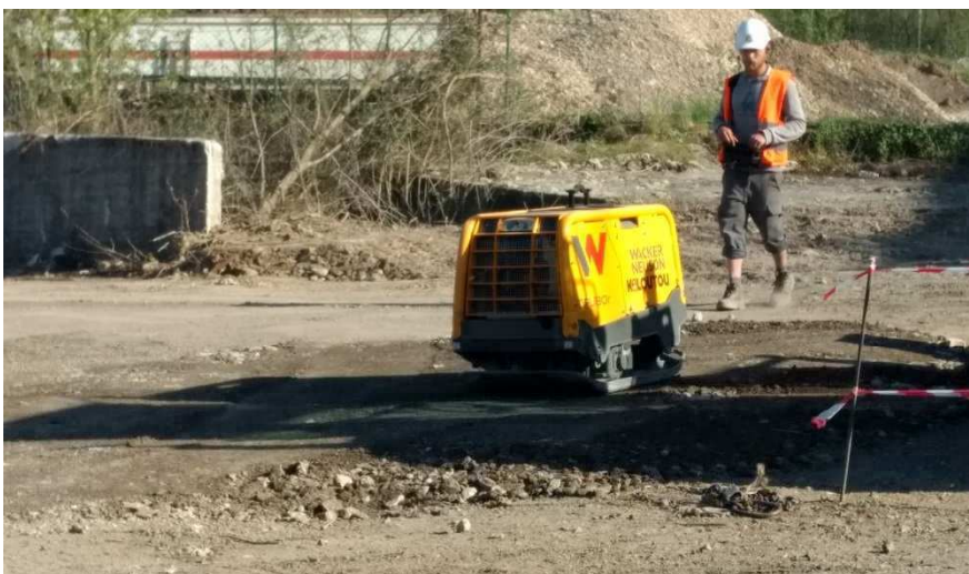
Compactage avec la plaque vibrante
